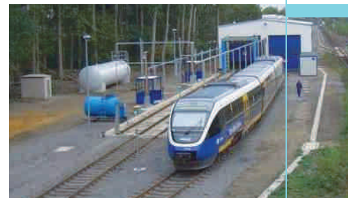
Bahnbetriebsanlagen Osnabrück, Dorsten, Boppard
