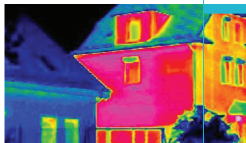
Gebäudeklassifizierung - Thermografie neu-alt
