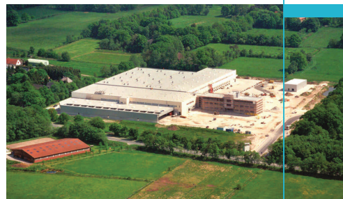
BÄKO Logistikzentrum Oldenburg ESFR - Sprinklerung (verzichtet auf Brandwände)
