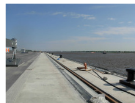
Inbetriebnahme des 1. Liegeplatzes
