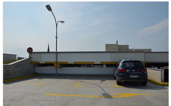
Parkdeck nach der Sanierung
