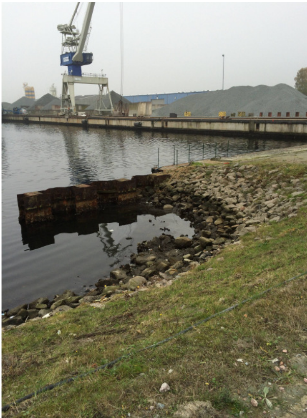
Nördlicher Bereich mit Rampe und Schwergewichtsmauer
